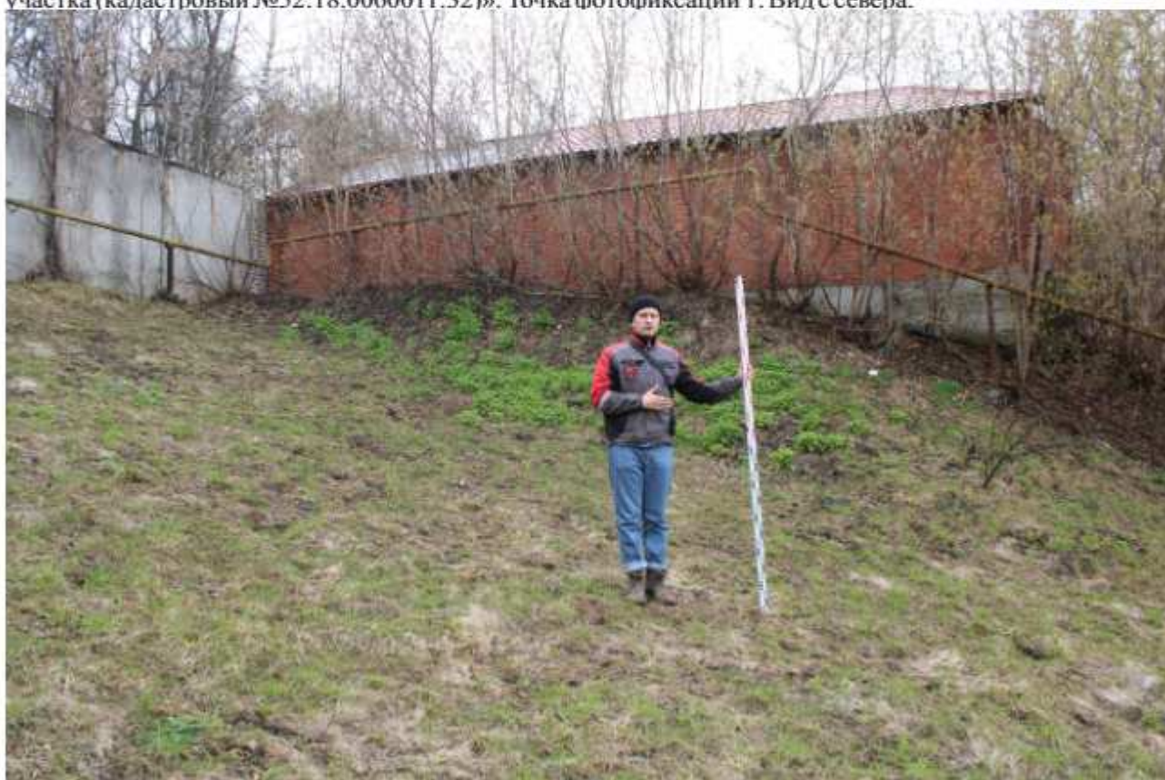
Илл.29. Общий вид земельных участков, отведенных под расположение проектируемого объекта: «Реконструкция водовода Д=500мм (кадастровый №52:18:0000000:9720). Водопроводная сеть Д=160 мм от точки присоединения в районе наб. Гребного канала до точки подключения на границе земельного участка (кадастровый №52:18:0060011:32)». Точка фотофиксации 1. Вид с востока.
